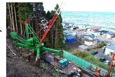
3 台目 (2 台目クレーンで部材を揚げ組立)
