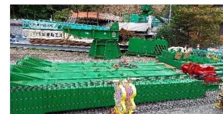
組立て前のクレーン部材
